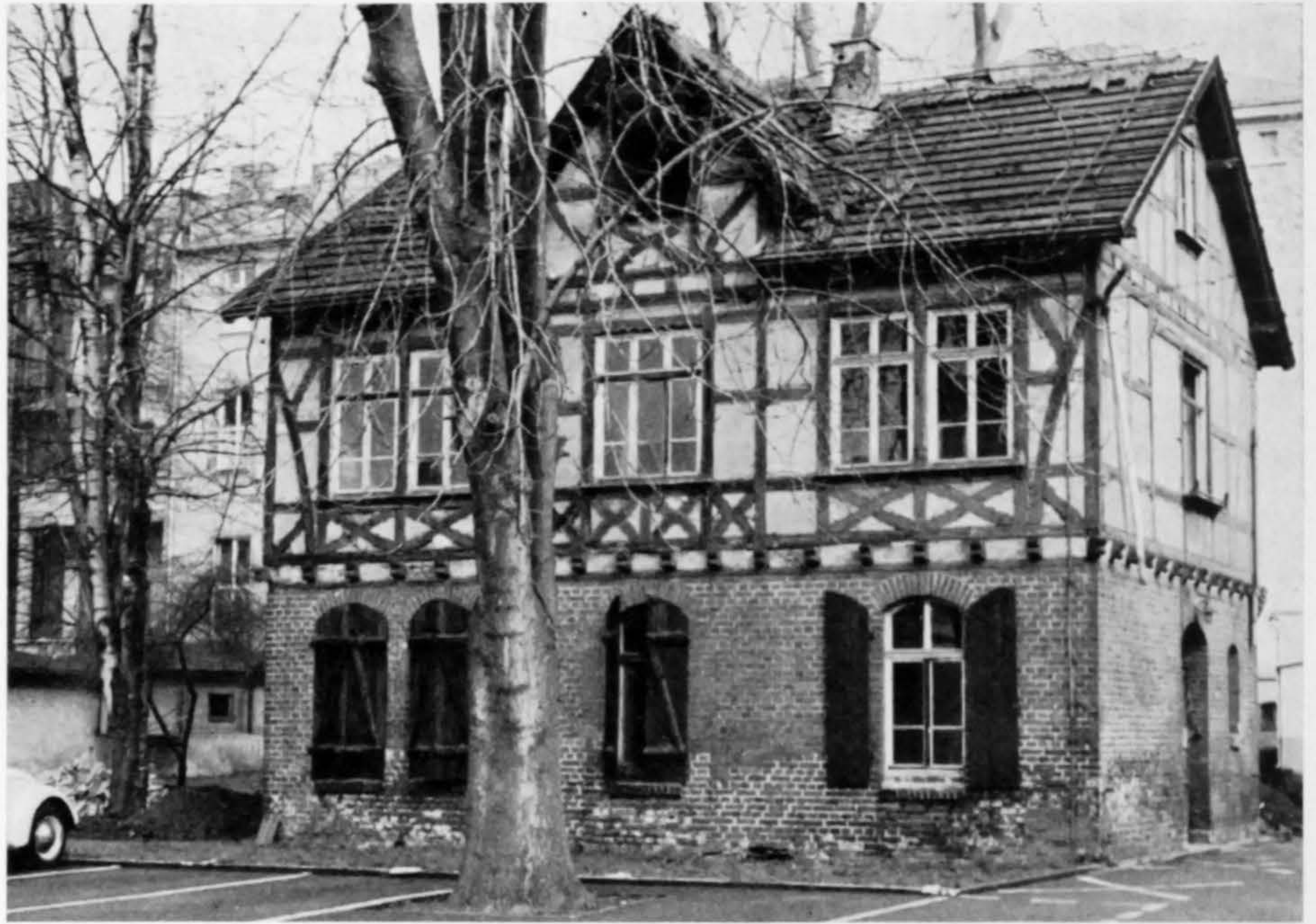
Das ehemalige Gartenhaus hinter dem Hause Bismarckstraße 22 in Gießen.
