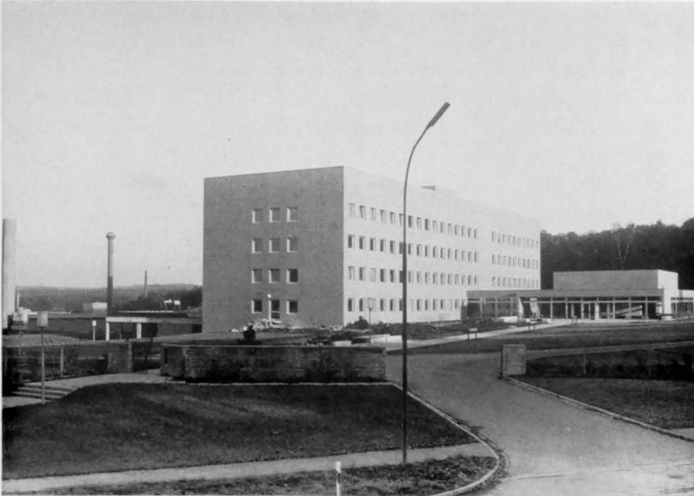
(1) Blick auf das Strahlenzentrum vom Leihgesterner Weg: Im Vordergrund Hörsaal und Lehrtrakt, beide links des Linearbeschleunigungsgebäudes (fot.: Dr. Waldvogel/Rase).
