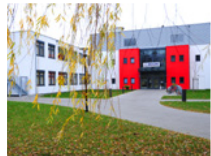
■ Abb. 7: Neubau des Exzellenzclusters, Baubeginn März 2008, Fertigstellung Oktober 2008
